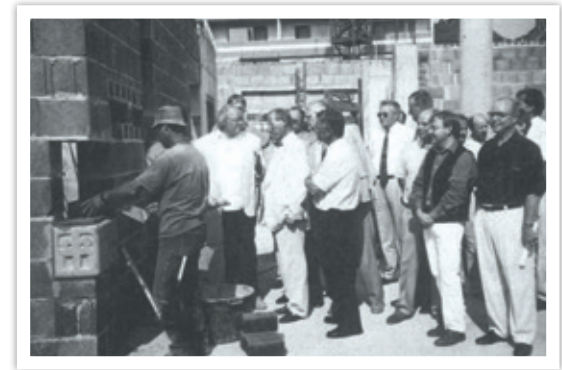
1995: Grundsteinlegung für das neue Martinsstift in Mainz
