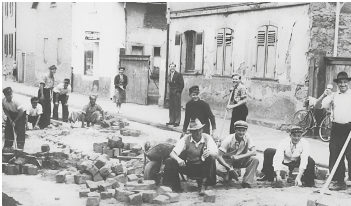
Nach der Verlegung der Kanalisation werden Pflastersteine in der Messeler Straße auf Höhe des Anwesens Frey und des Friseurgeschäfts Best Mitte der 1950er neu verlegt. (Foto: AGV)
