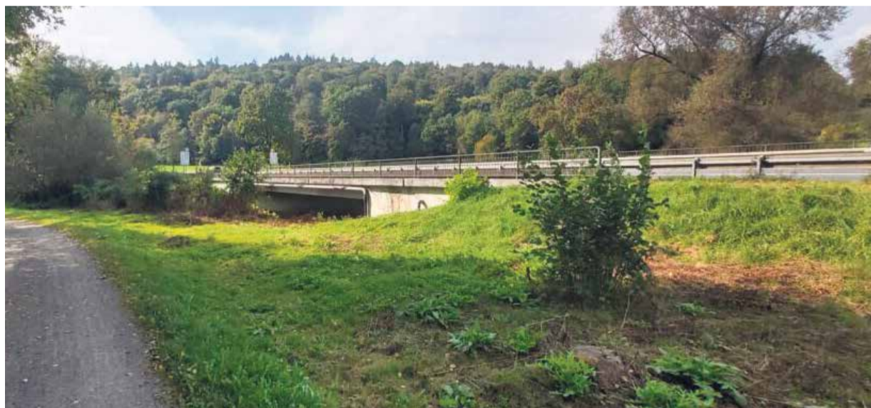
Die Brücke über die Mümling soll erneuert werden – dazu ist eine Behelfsbrücke geplant, damit der Verkehr weiter fließen kann. Foto: Hessen Mobil
