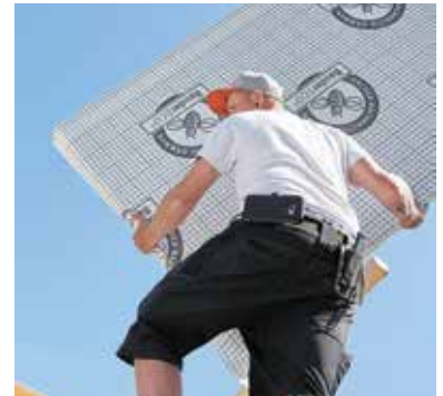
Dämmmaterialien mit hoher Leistung ermöglichen vergleichsweise schlanke und somit leichte Aufbauten.
