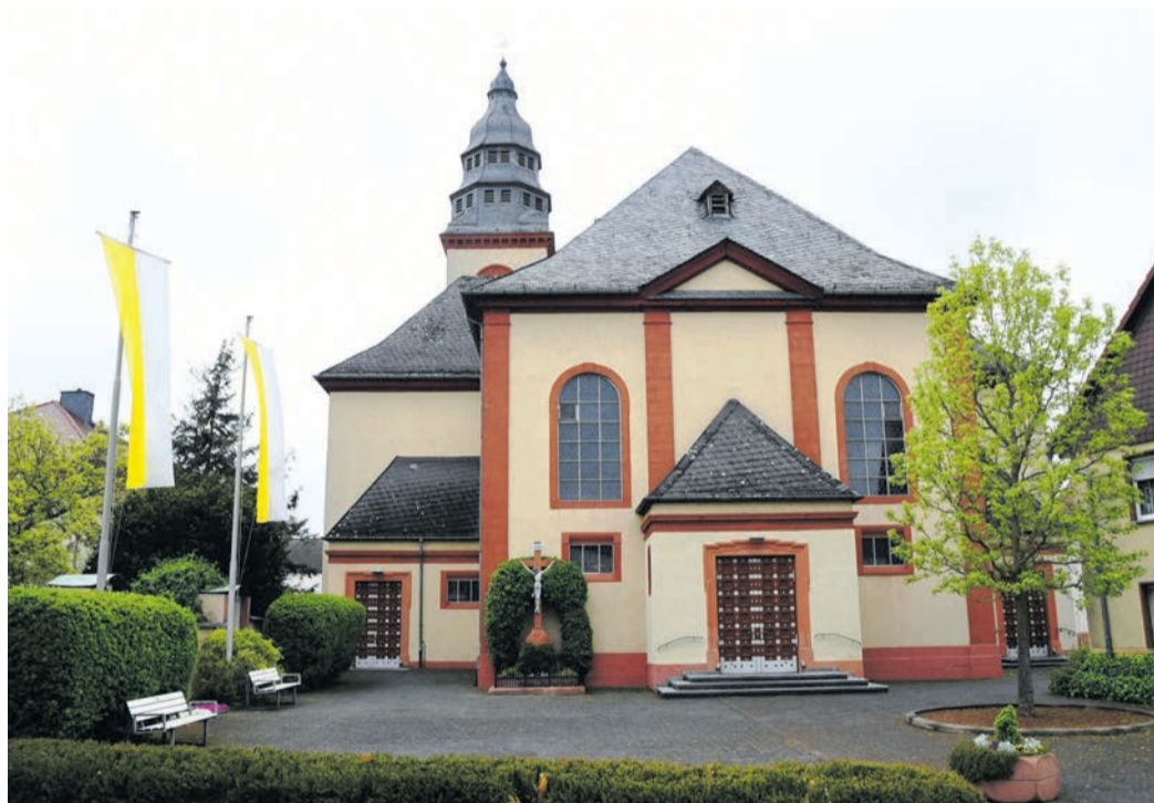
In und an der Münsterer Kirche St. Michael stehen die nächsten Investitionen an. Sie sind mit 100 000 Euro veranschlagt. Die Hälfte davon muss die Pfarrei aus eigener Kraft aufbringen. Die Spendenbereitschaft ist hoch. (Fotos: jedö)
