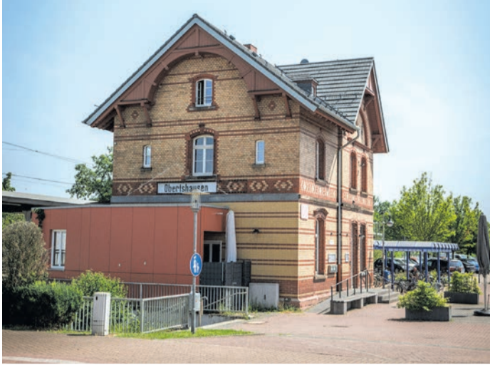
Ein neuer Pächter wird für den Gastronomiebereich des ehemaligen Bahnhofsgebäudes gesucht. Bis spätestens 31. Oktober schließt das dortige Café Herzglück seine Türen.
