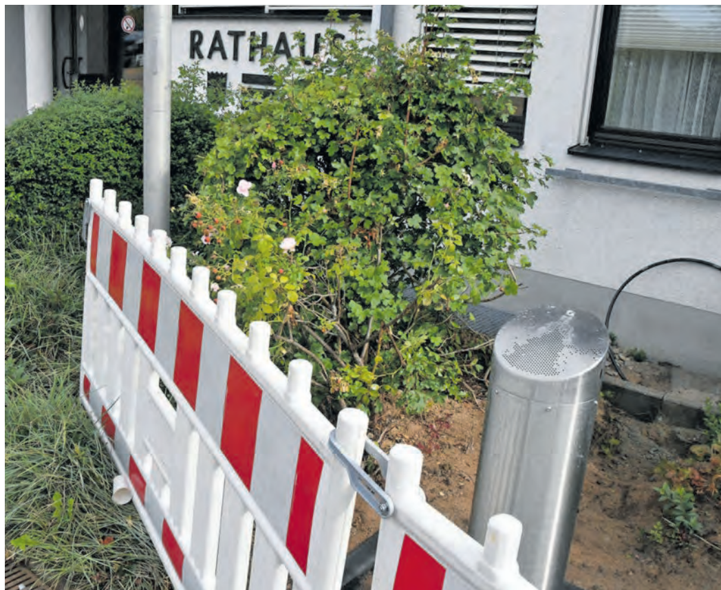
Der Trinkwasser-Brunnen neben dem Rathaus-Eingang ist endlich installiert. Nutzen können ihn die Besucher des Franz-Gruber-Platzes aber erst nach der Freigabe durchs Gesundheitsamt. (Foto: jedö)
