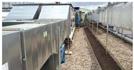
viel Technik auf dem Dach
