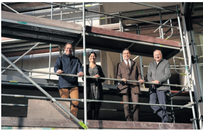
Erklommen gemeinsam das Baugerüst (von rechts): Landrat Oliver Quilling, Obertshausens Bürgermeister Manuel Friedrich, Schulleiterin Anja Bechtloff und Kreisbeigeordneter Alexander Böhn. (Foto: Kreis Offenbach)
