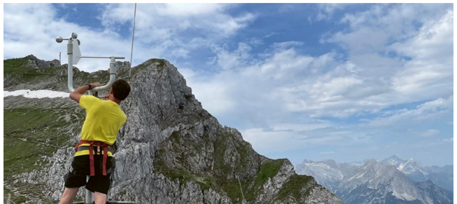
Oliver Nitsche wartet die Wetterstation an der Karwendelbahn. Foto: MME
