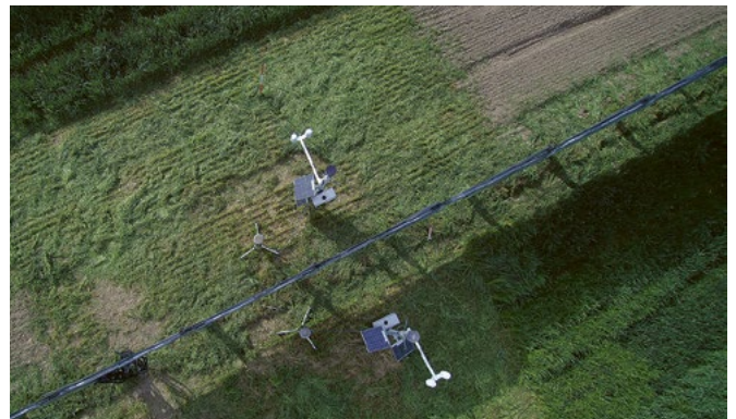
MME-Wetterstationen erfassen das Mikroklima in einer Agrivoltaikanlage auf der Versuchsfläche Pillnitz (Dresden). Foto: Karl Wild
