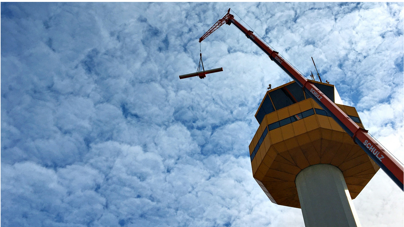
Auf dem Tower Hamburg wird die Radar-Antenne ausgetauscht. (Foto: Andreas Lubosch, DFS)
