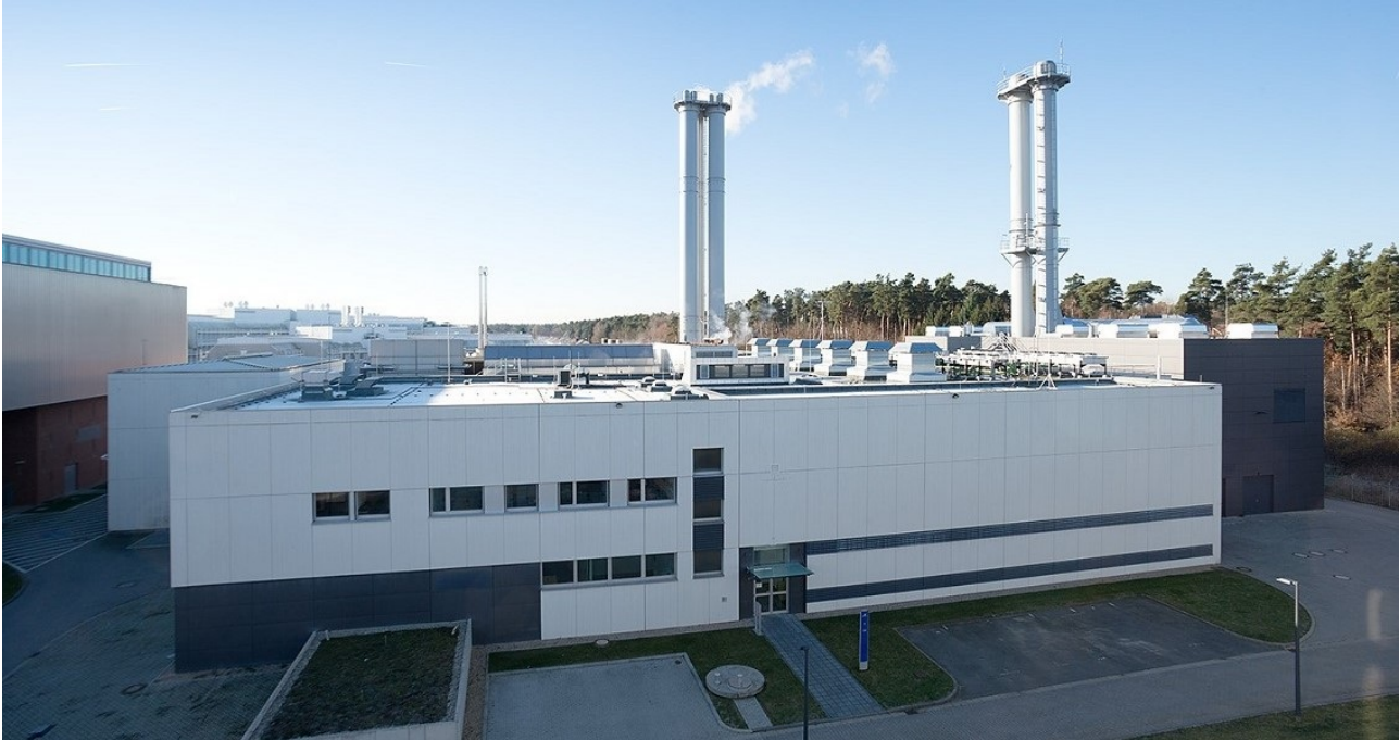
Die Energiezentrale (DFS Energy GmbH) versorgt den DFS-Campus sowie benachbarte Behörden mit Strom, Wärme, Kälte und Dampf. (Foto: Hans-Jürgen Koch, DFS)
