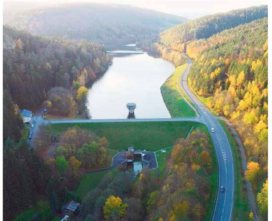
Auch der Marbach-Stausee als Südhessens größte Hochwasserschutz-Anlage wird besucht.
