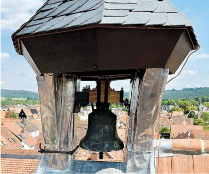
Endlich ist sie wieder da und bereit zum Läuten: Die Glocke im historischen Michelstädter Rathaus wurde saniert. Foto: Stadt Michelstadt
