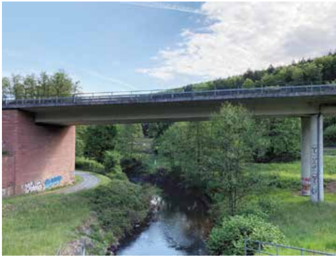
Bald soll die "Zeller Brücke" abgerissen werden. Foto: Hessen Mobil
