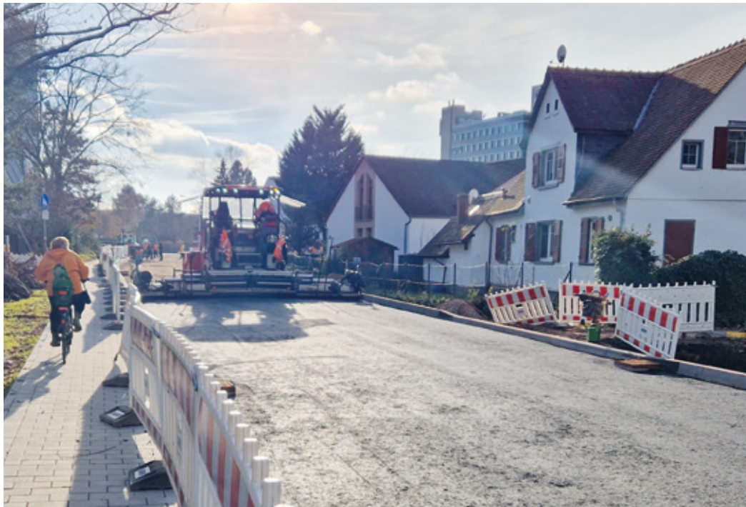
Derzeit wird die erste Teerschicht auf der Jägertorstraße zwischen Waltherstraße und Gruberstraße aufgebracht, hier neben der Kleinen Kirche am See (links) mit Blick zur Kreuzung Gruberstraße. Freudig begrüßt wurde von Teilnehmern der Stadtteilrunde, dass der nun ausgebaute Fußweg entlang dem Brentanensee bereits freigegeben ist. (Foto: dv)
