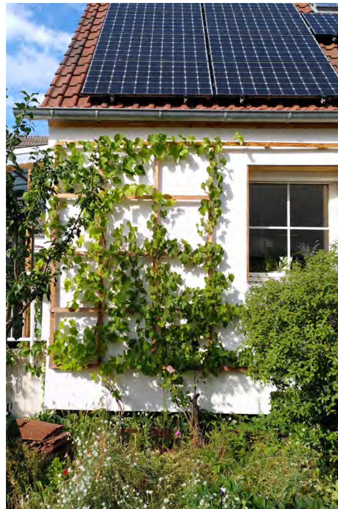
Abbildung 87: Wandgebundene Fassadenbegrünung mit echtem Wein in Eigenregie an gedämmter Hausfassade. Quelle: Dr. Patrick Voos
