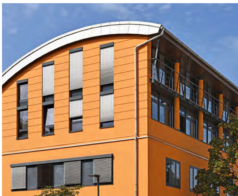
Abbildung 99: Vorbildhafte Klimaanpassung in Form von energetischer Sanierung und außenliegendem Sonnenschutz. Foto: HMLU
