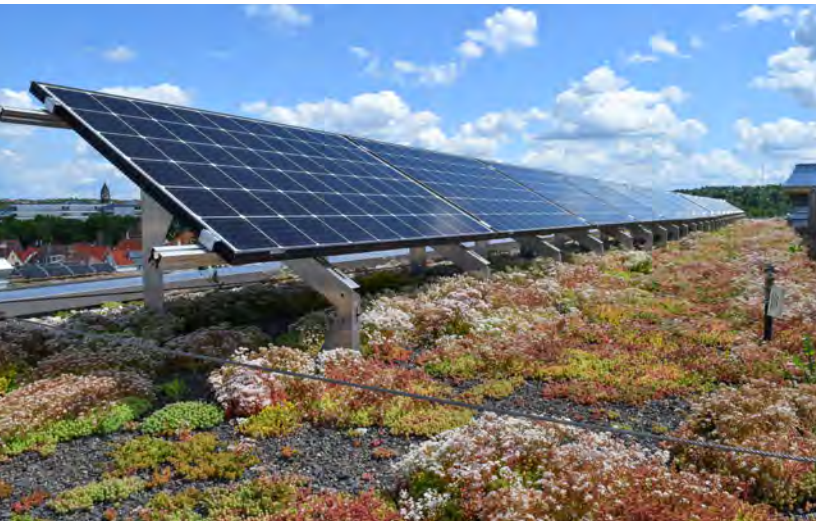
Abbildung 83: Kombination aus PV & Gründach. Quelle: Bundesverband Gebäudegrün e. V.
