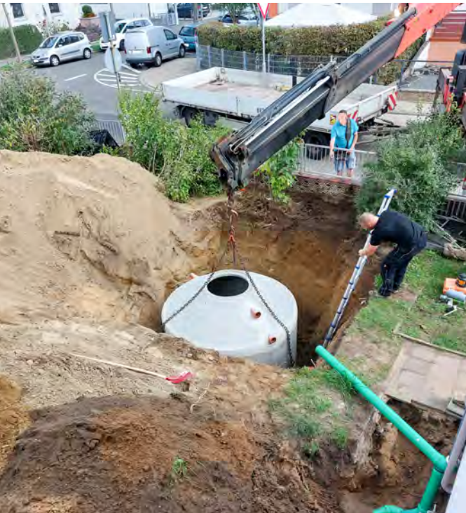
Abbildung 69: Einbau einer von der Wissenschaftsstadt Darmstadt geförderten Zisterne. Quelle: Christoph Schulze
