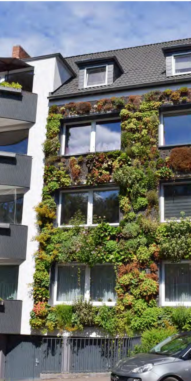
Abbildung 86: Wandgebundene Fassadenbegrünung. Quelle: Bundesverband Gebäudegrün e. V.
