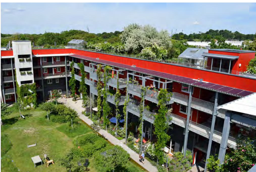
Abbildung 82: Kombination aus intensiver Dachbegrünung und bodengebundener Fassadenbegrünung. Quelle: Bundesverband Gebäudegrün e. V.
