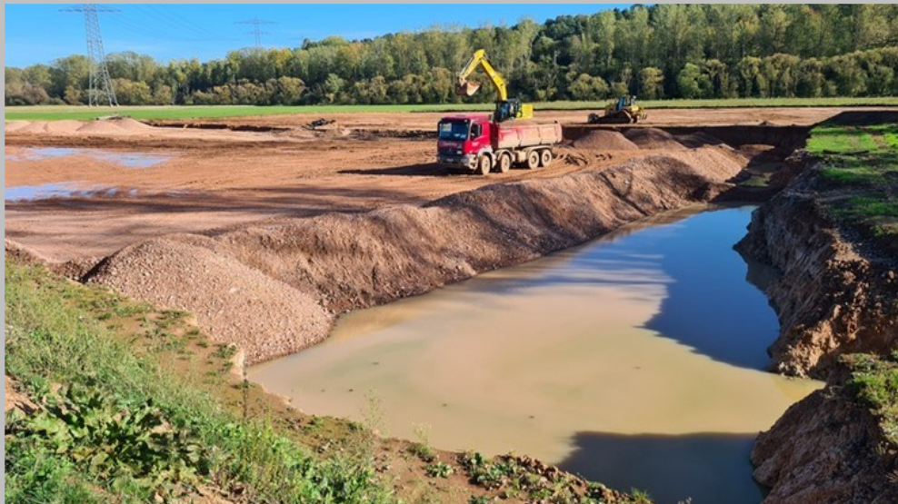
Ansicht 110: Auskiesung an der Fulda, Freilegung der Kiesschicht; eigene Aufnahme vom 16. Oktober 2024
