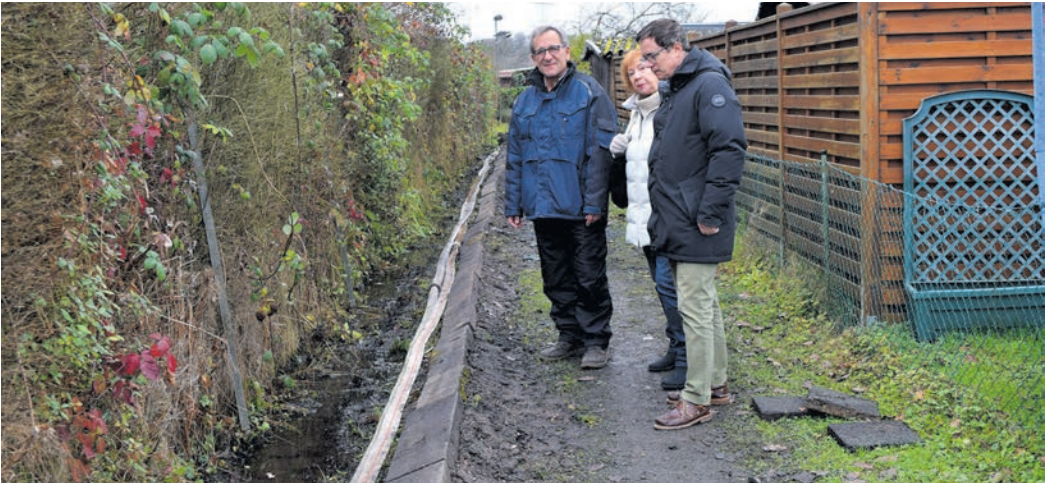
Bei der Ortsbegehung sind die Schäden unübersehbar.
