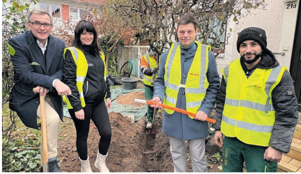
Symbolischer Spatenstich für den Start der Bauarbeiten für die Hausanschlüsse zum Glasfasernetz der Westconnect. Von links: Bürgermeister Steffen Ball, Melanie Böttger (Qualitätsmanagerin Deutsche Infrabau), Matthias Nass (Projektleiter Hessen Westconnect), Eli Mislim (Bautrup der Deutsche Infrabau). (Foto: Caterina Gams/Magistrat)
