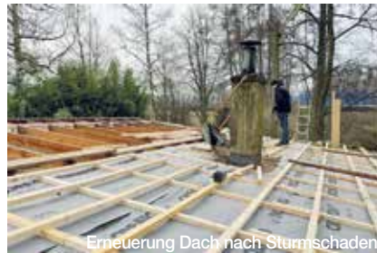
Erneuerung Dach nach Sturmschaden
