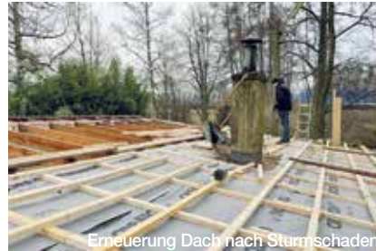
Erneuerung Dach nach Sturmschaden
