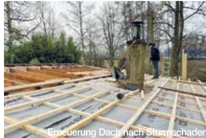
Erneuerung Dach nach Sturmschaden
