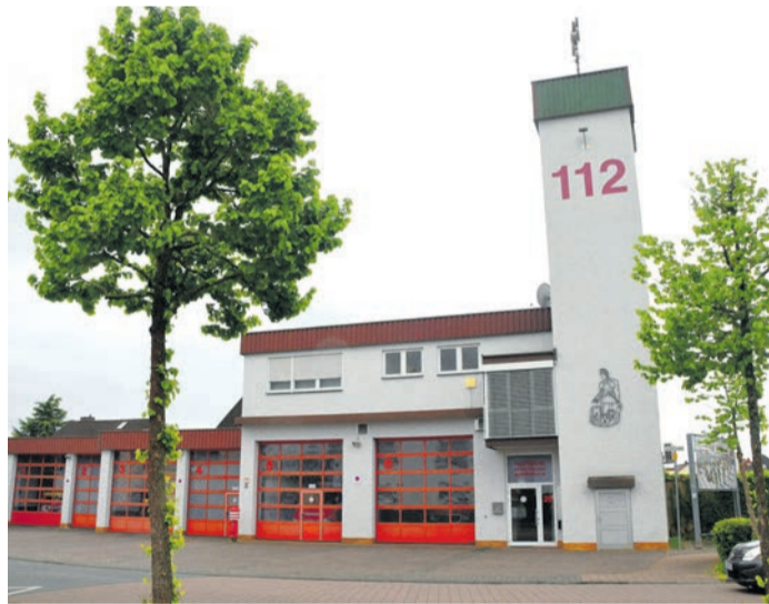
Der Feuerwehr-Stützpunkt im Niederfeld soll 2026 ein neues Dach bekommen. Anschließend soll dort auch eine Photovoltaik-Anlage installiert werden. Die größte investive Ausgabe der Gemeinde Eppertshausen wird auch in diesem Jahr in den Ausbau der Gehwege fließen. (Foto: jedö)
