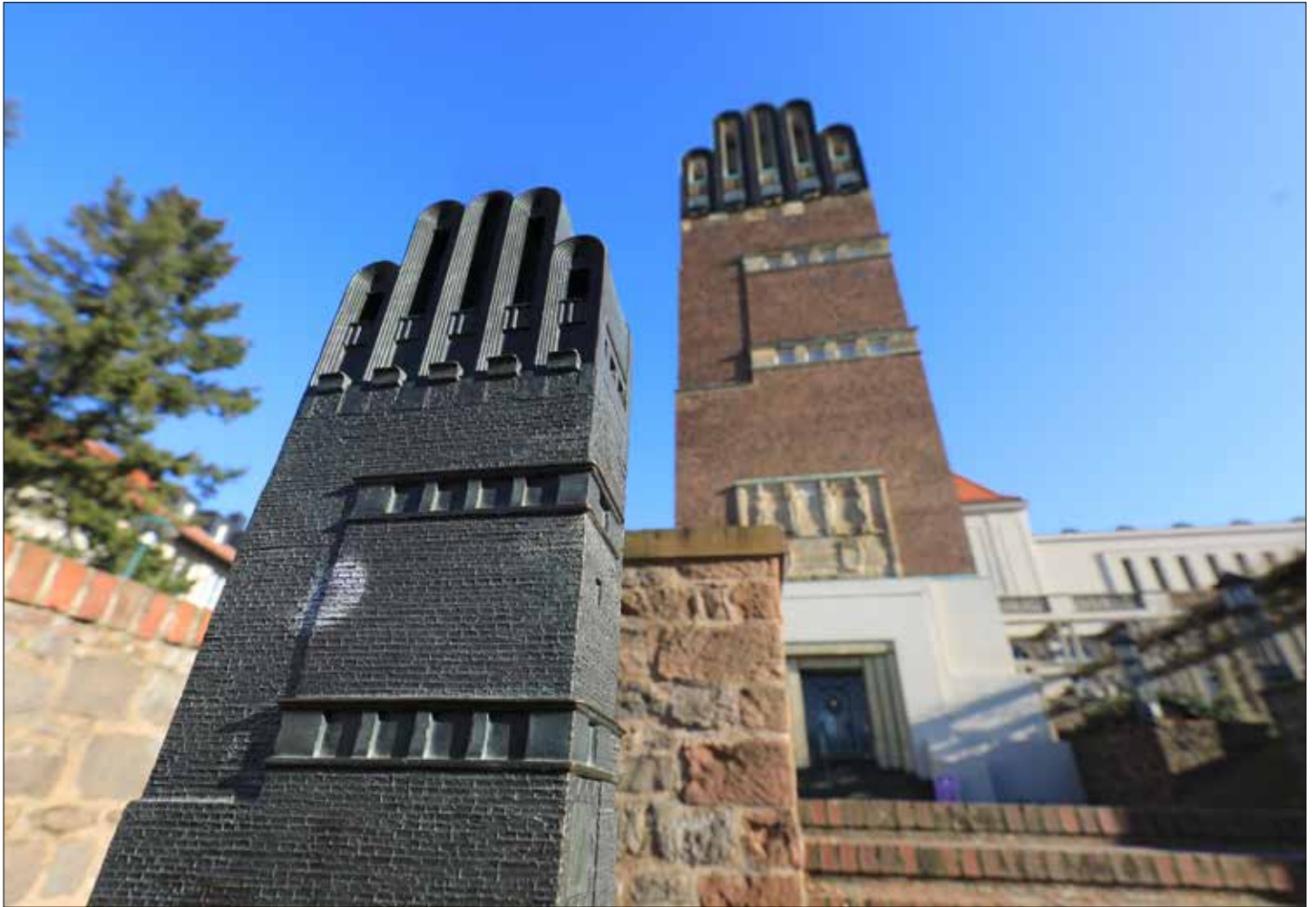
Der Darmstädter Hochzeitsturm nach der Sanierung.
