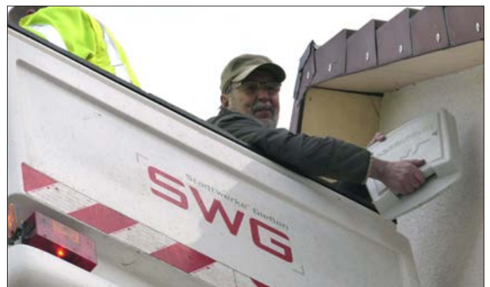
Gerade die Montage von Fledermauskästen in luftiger Höhe ist wegen deren Gewichtes nicht einfach. (Foto: Mattern)
