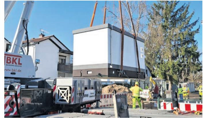
Mit Hilfe eines Krans wurde das Glasfaser-Verteilergebäude sicher an seinem Standort an der Albert-Schweitzer-Straße platziert. Foto: Christina Schäfer/Stadt Obertshausen
