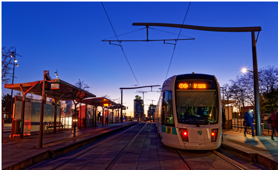
Abbildung 23: Fahrleitung kann auch eine Chance für gelungene Stadtarchitektur sein – ein gutes Gesamtkonzept zahlt sich aus. Straßenbahnlinie T3 in Paris – Foto: Torsten Giesen
