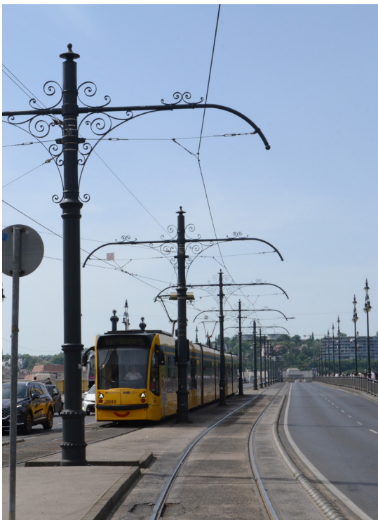
Abbildung 14: Auch in städtebaulich sensiblen Gebieten oder in historischen Ensembles ist eine Lösung mit einer ästhetischen Fahrleitung machbar (Margarethenbrücke in Budapest) – Foto: U. v. Stockhausen
