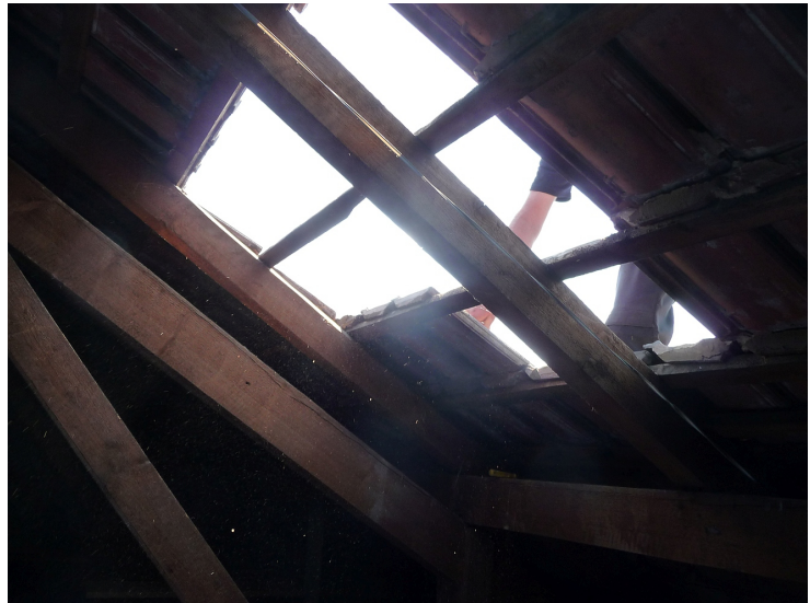
So sah es aus, als im Zuge der der Pauluskirche das Dach abgedeckt wurde
