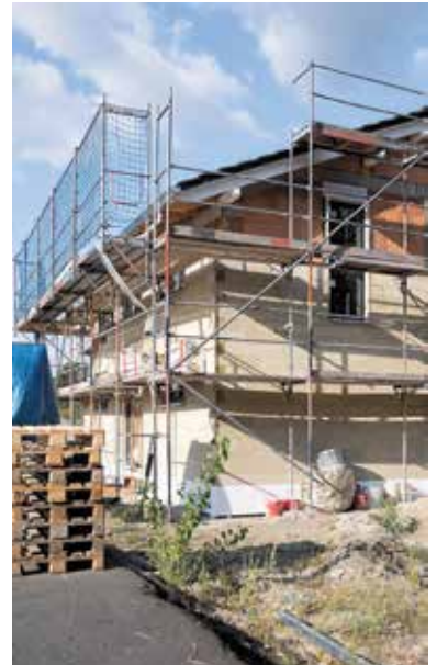
Ernstfall Insolvenz: Die Baustelle liegt verlassen da und das Eigenheimprojekt gerät in Gefahr.
