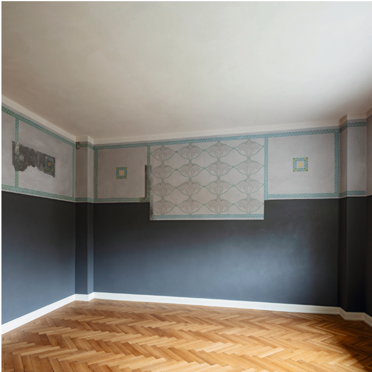
49.1 Rekonstruktion der Schablonenmalerei von 1908 und farbig gefasste Wände, 2025
