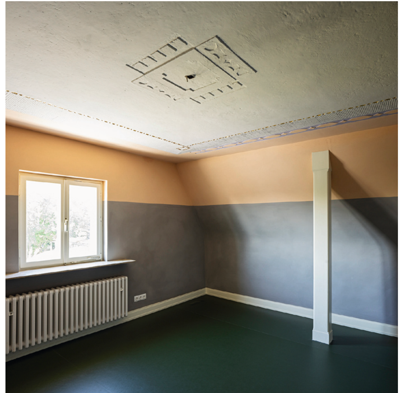
37.1 Restaurierte Decke im Fremdenzimmer mit farbig gefassten Wänden, 2025
