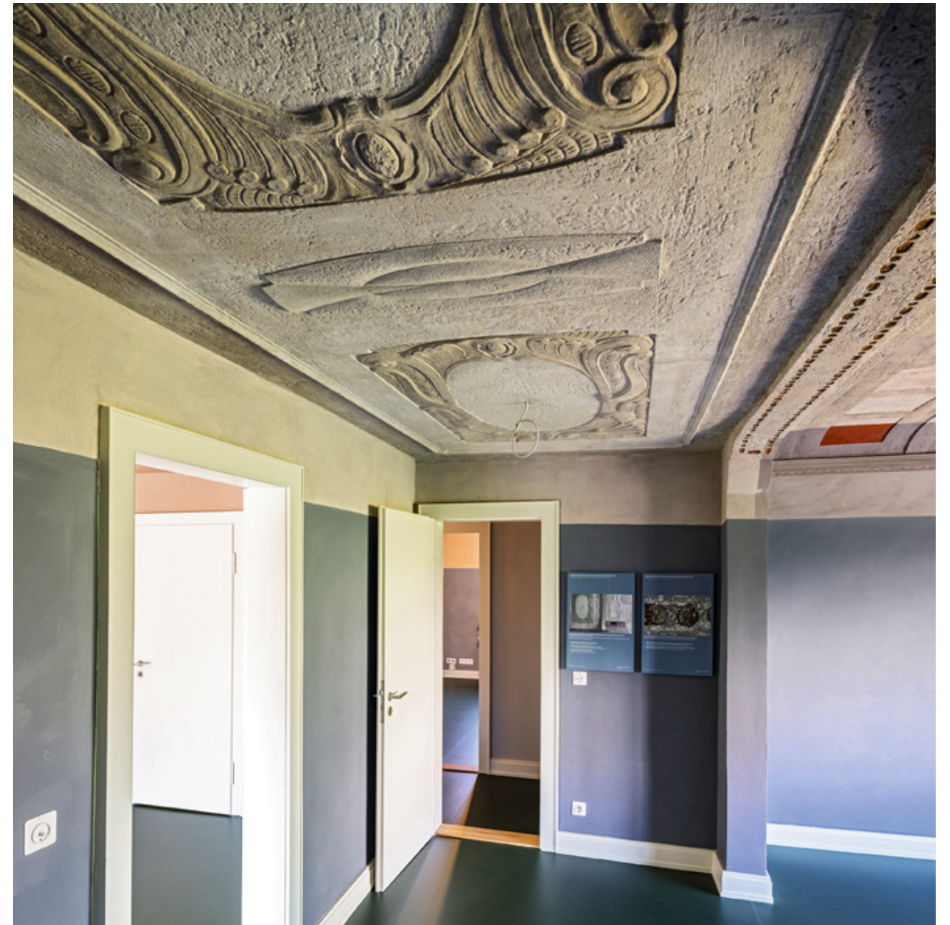
35.1 Restaurierte Decke mit farbig gefassten Wänden, 2025
