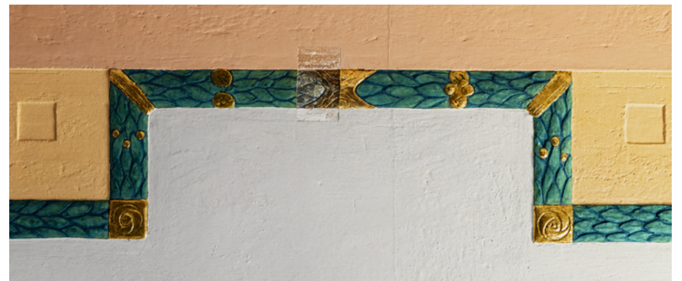
33.2 Rekonstruktion der Fassung und Metallisierungen von 1908 und Integration der Befundfenster, 2025
