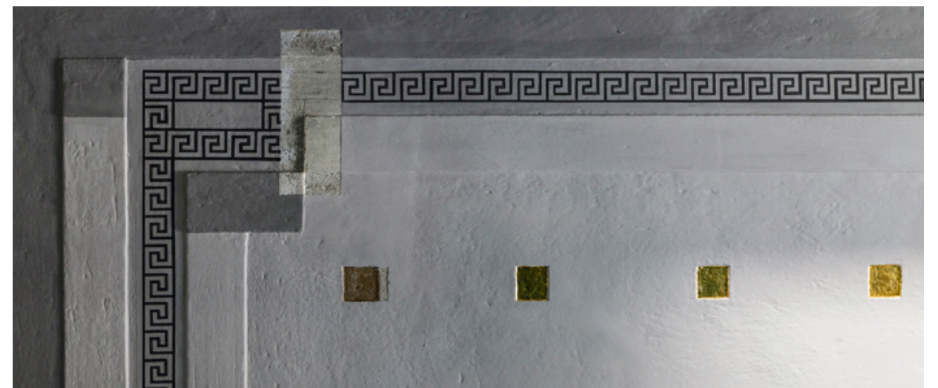
31.2 Rekonstruktion der Fassung und Metallisierungen von 1908 und Integration der Befundfenster, 2025
