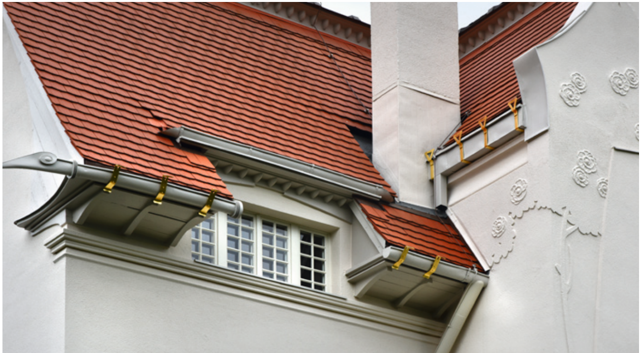
25.1 Neue Dacheindeckung in naturrotem Biberschwanz und restaurierte Dachzier, 2023
