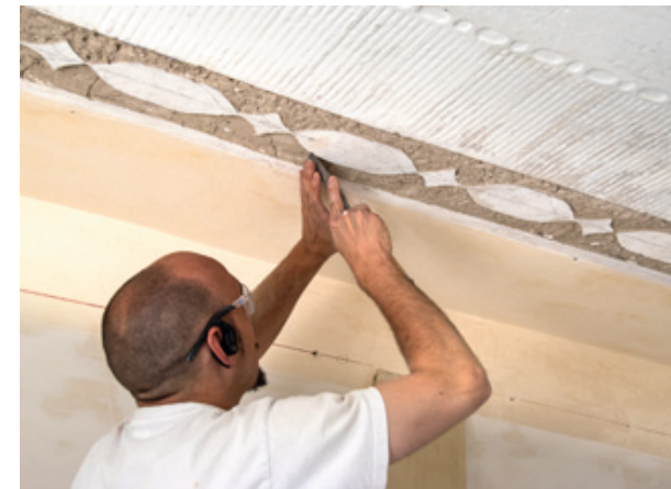
27.1 Rekonstruktion des umlaufenden Frieses an der Decke im Fremdenzimmer im Mansardgeschoss, 2022
