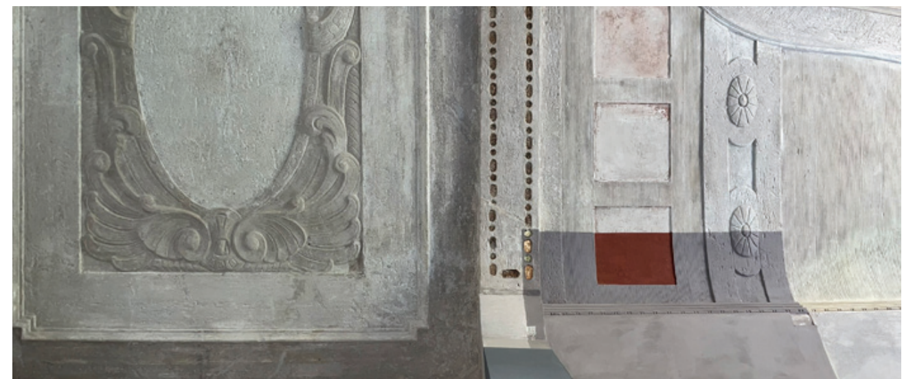
35.2 Decke in Kratzputztechnik mit Stuckprofilen und fragmentierter bauzeitlicher Farbgestaltung (Leimfarbe) nach Freilegung im chemischen Beizverfahren, 2025
