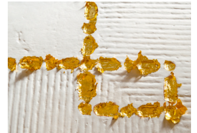
27.2 Wiederherstellung der Metallisierung an der Decke im Fremdenzimmer im Mansardgeschoss, 2022
