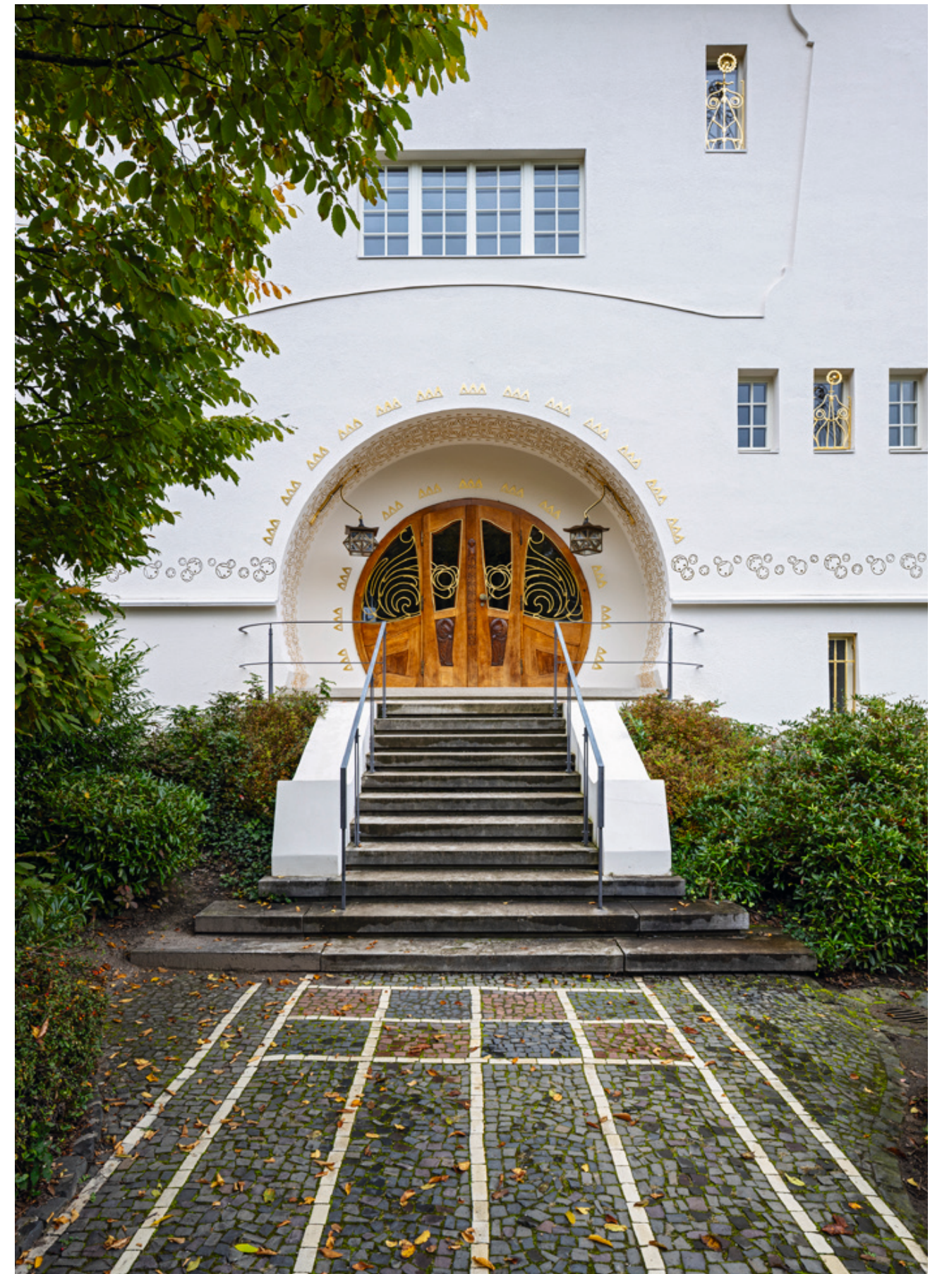
5.1 Restaurierter Zustand der Fassade und des Omegaportals, 2025
