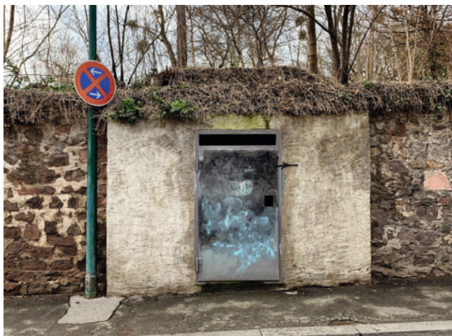
Eingang zum Schutzbunker unter dem Wolfskehl'schen Park
