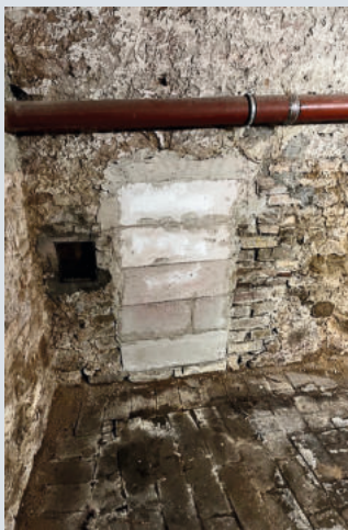
Vermauerter Kellerdurchbruch, Kranichsteiner Straße
