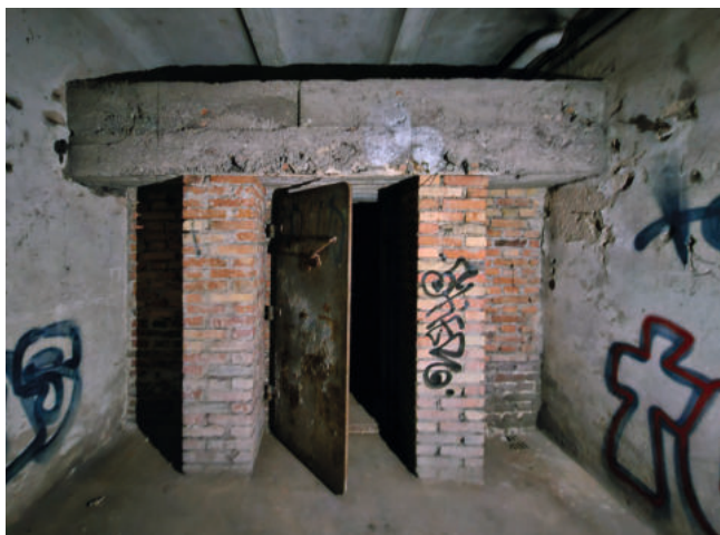
Zugang zum Schutzraum
