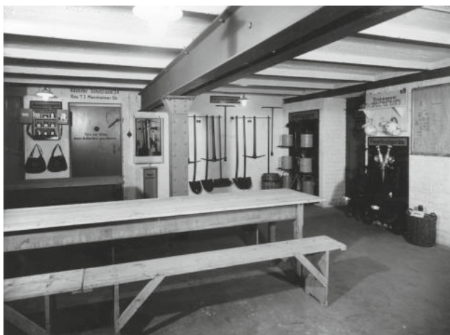
Blick in einen Luftschutzraum (1939)
