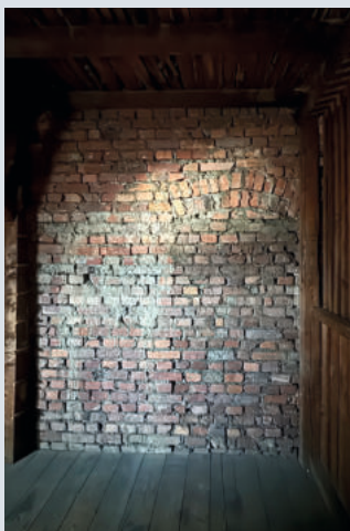
Vermauerter Wanddurchbruch im Dachgeschoss, Barkhausstraße
