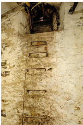
Eisenbügel wurden montiert, um die Ausstiegs Luke zu erreichen.
