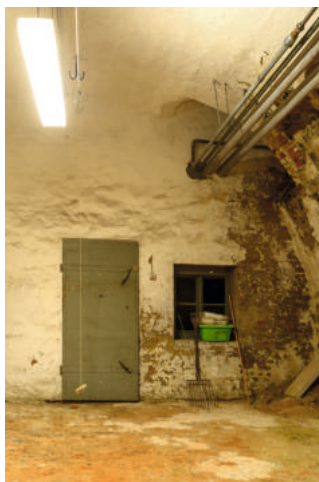
Schutzraum mit Tonnengewölbe und Luftschutztür
