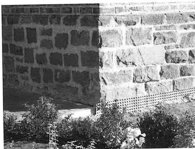
Abb.30 Fachgerecht verfugter Gebäudesockel
