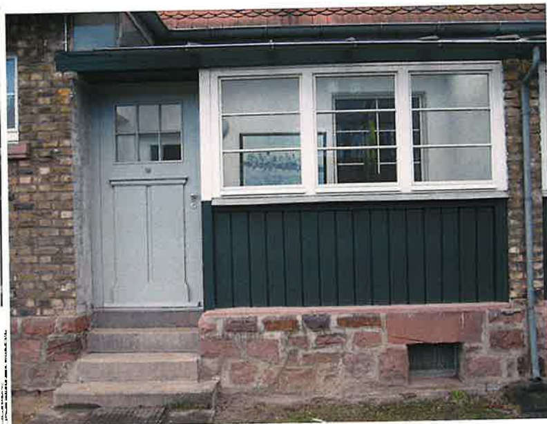
Abb. 40 Erneuerter Wintergarten in Zusammenarbeit mit der Denkmalpflege
