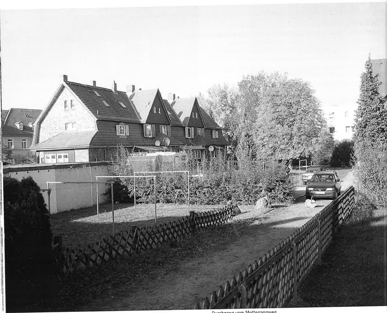
Durchgang vom Mettegangweg
