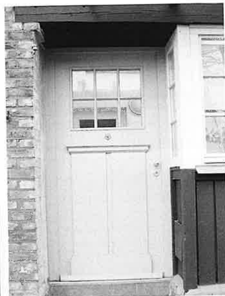
Abb.24 Neue Haustür in der Michaelisstraße
