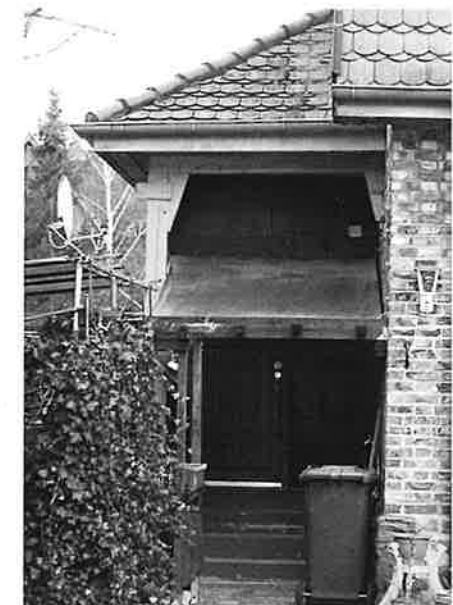
Abb.4 Verunstaltende Einbauten im Eingangsbereich des Hauses
